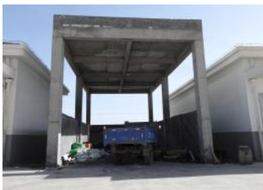
锅炉房贮煤棚
