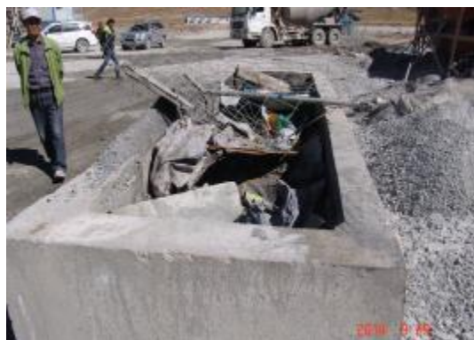
施工垃圾集中收集
