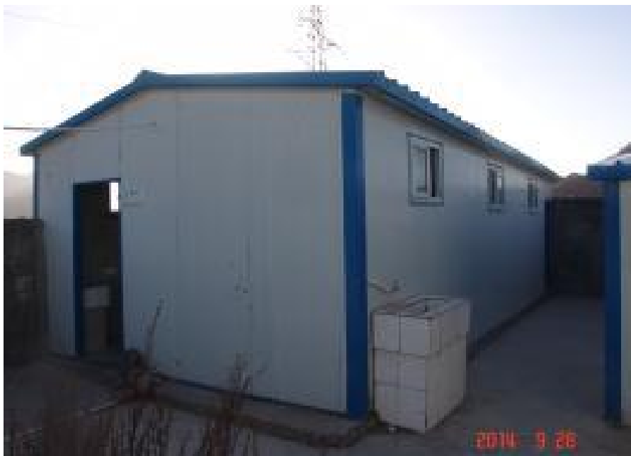
施工营地旱厕
