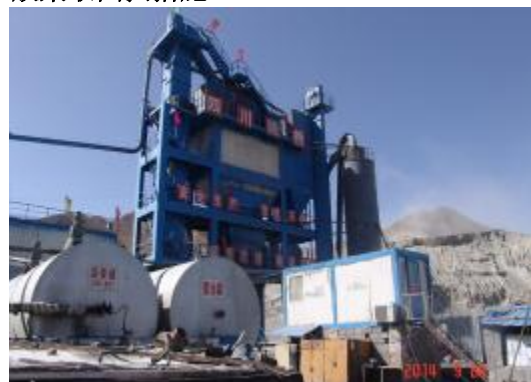
拌合站上料封闭
