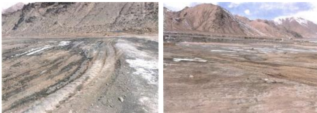
施工场地废物清理完成
