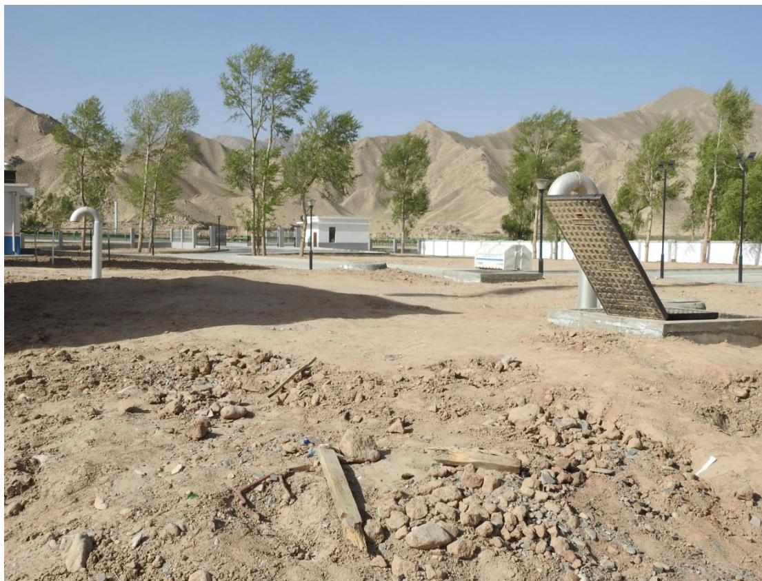
图 8.3-1 地埋式污水处理系统
